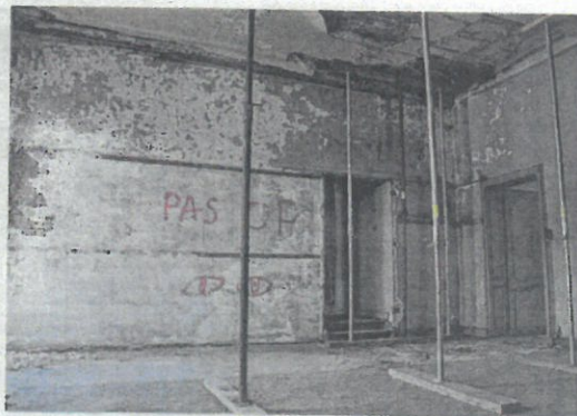
Het gebouw moest op vele plaatsen gestut worden. © ktb
